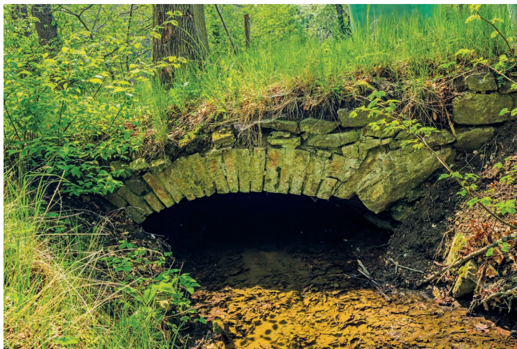
▲ Rybník Dolní Nadýmač pod Hrádečkem v povodí Melhutky vyrovnával průtok vody ve stoce. U výtoku z Dolního Nadýmače nalezneme cihlový, patrně renesanční klenutý můstek, fotografie z roku 2022
