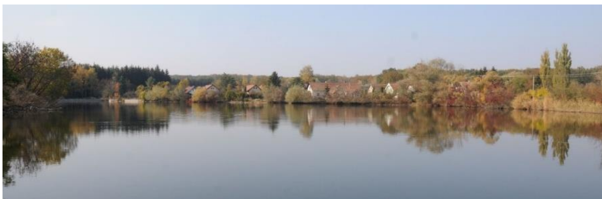
Hráz rybníka Dolení komora s jižním okrajem zástavby Malého Nouzova (foto: K. Kuča, 2018).
