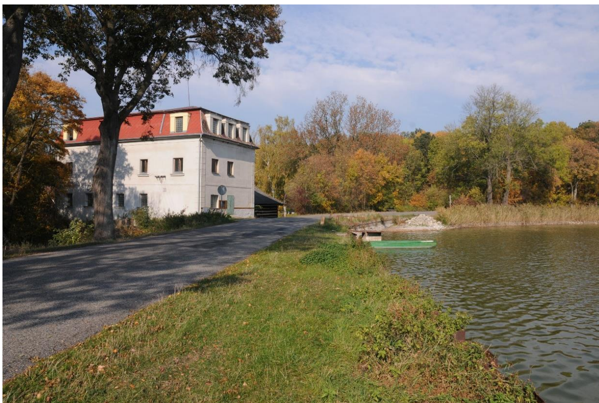
Hráz Jakubského rybníka s Jakubským mlýnem – historická a památkově chráněná roubená část mlýna je skryta pod hrází (foto K. Kuča, 2018)
