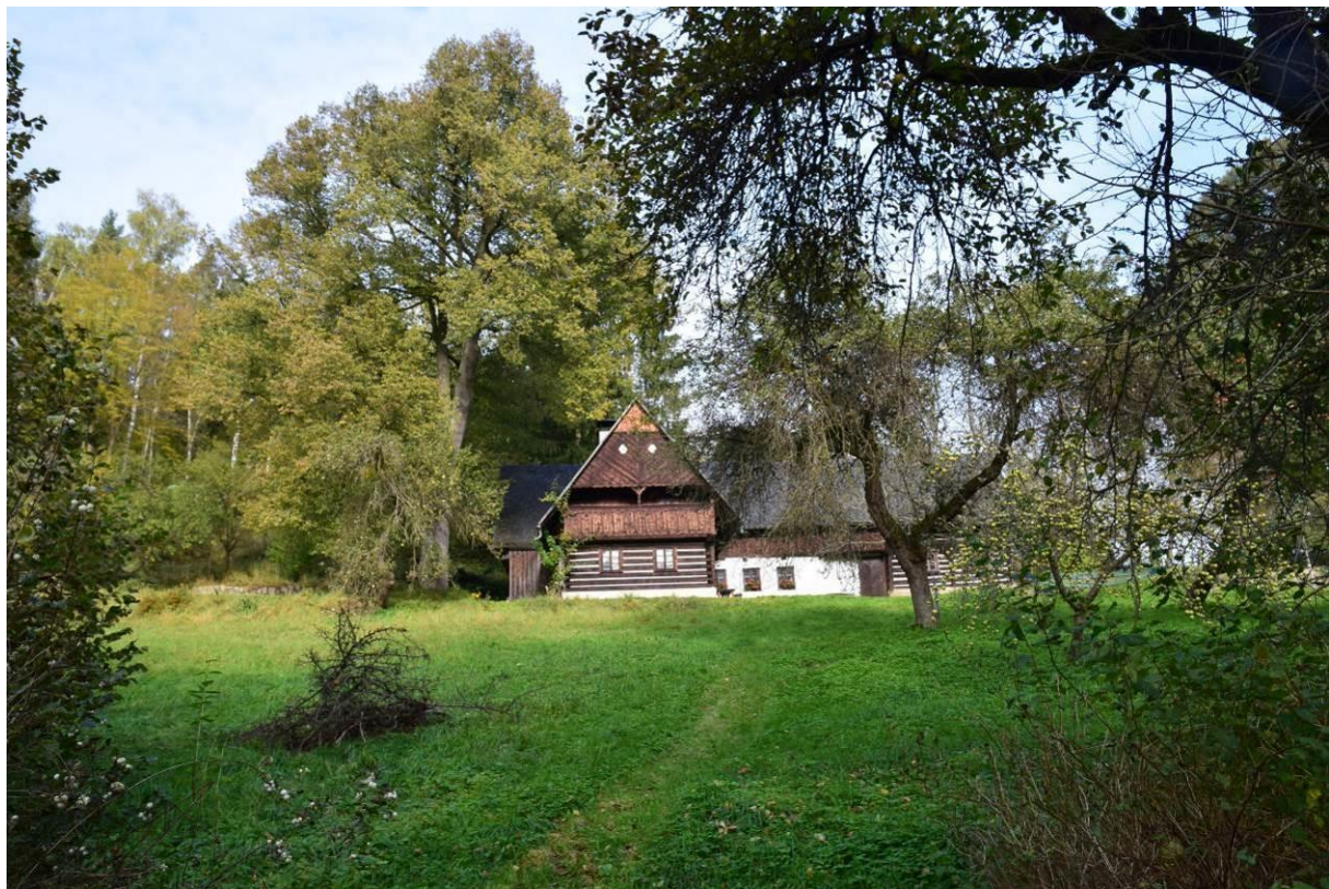
Roubený dům se špýcharovým polopatrem nad světnicí a roubená novostavba z 90. let 20. st. s pavlačí ve štítě na místě původní stodoly v Trávníčku č. p. 11.
