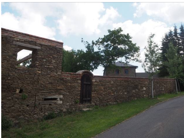
Obr 153: Citlivě rekonstruovaná bývalá tvrz v Žišově. Foto: M. Šantrůčková, 2022
