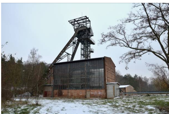
Obr 9: Těžní věž dolu Turkaňk. Foto: O. Malina, 2019
