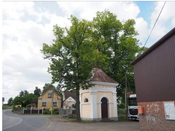
Obr 169: Návesní kaple v Mačicích. Foto: M. Šantrůčková, 2022
