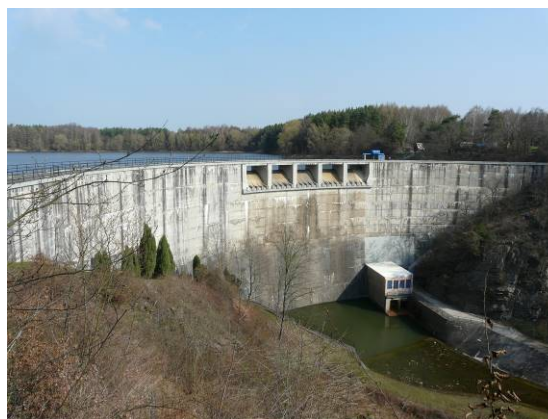
Obr 18: Hráz nádrže Vrchlice. Foto: K. Kiri, 2017
