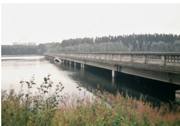
Obr 104: Nedostavěný most „Hitlerovy dálnice“ u Borovska. Foto: O. Malina, 2002
