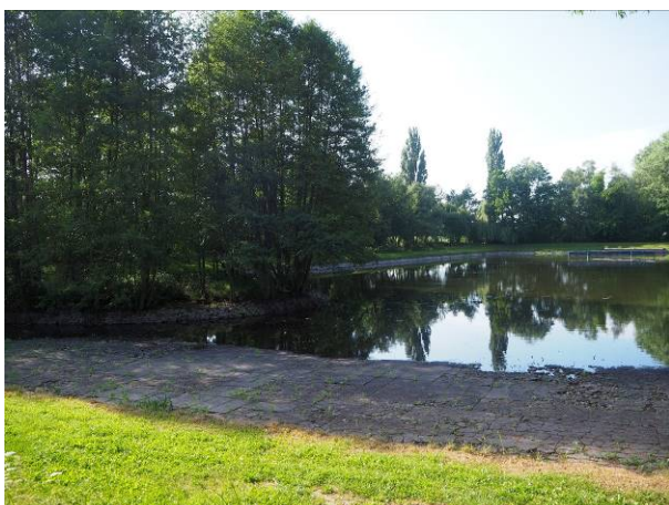
Obr 226: Koupaliště bylo vybudováno na místě jednoho z rybníků, vlevo je vidět umělý ostrůvek. Foto: M. Šantrůčková, 2022
