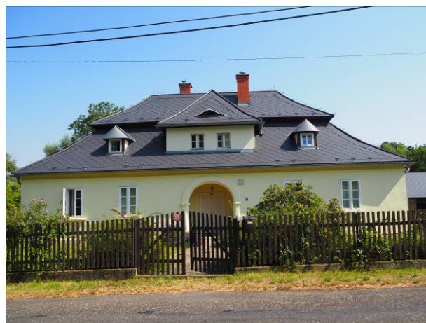
Obr 94: Bývalá fara v Sudějově. Foto: M. Šantrůčková, 2020
